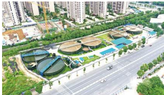
广西桂林污水处理项目
