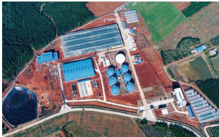
江西新余区域粪污集中处理中心
