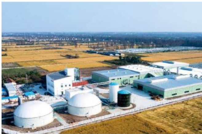
上海电气环保集团崇明岛项目
