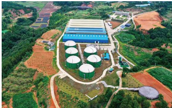
江西赣州锐源规模化沼气发电项目
