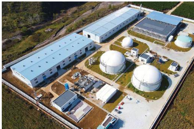
华电集团丰宁生物质沼气项目
