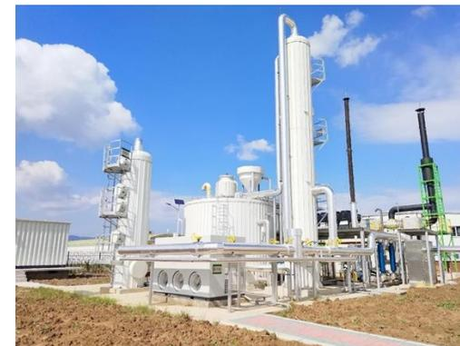
该项目采用了全量化粪污处理技术，年处理粪污量不低于50万立方米。奶厅污水及牧场生活污水经过深度处理，确保排放达到1级A标准。
