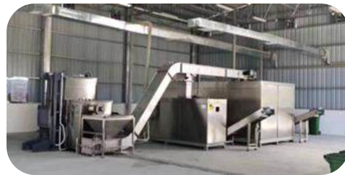
新兴县天堂镇餐厨垃圾处理点
