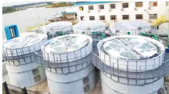
广东汕头市政污水处理项目
