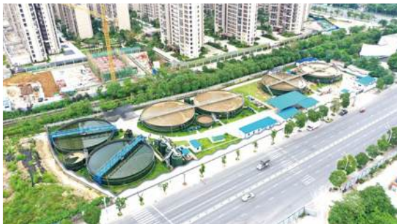
广西桂林污水处理项目
