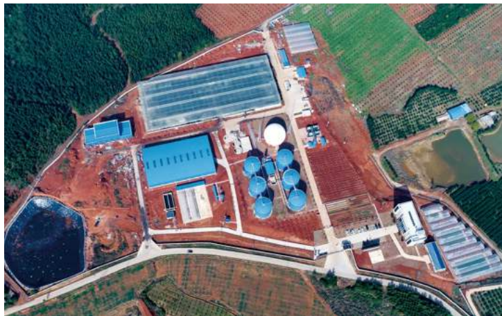
江西新余区域粪污集中处理中心
