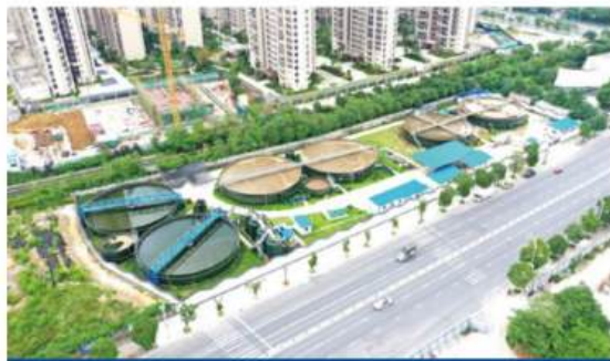
广西桂林污水处理项目
