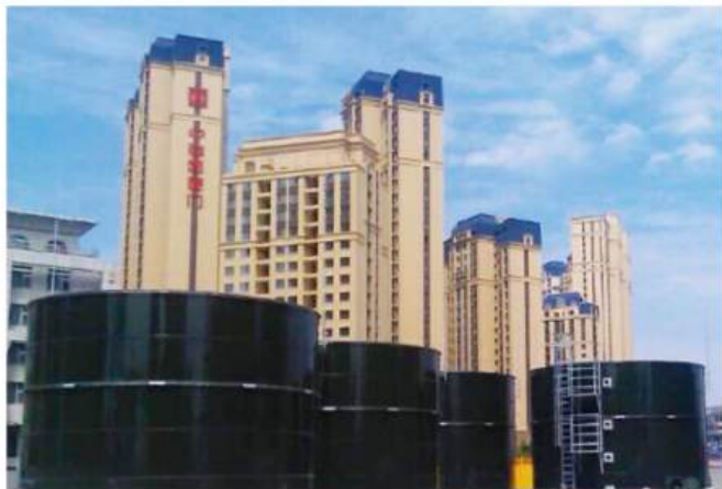
地铁工程泥浆储罐
