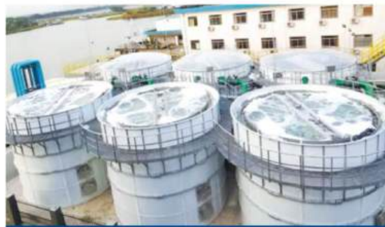
广东汕头市政污水处理项目
