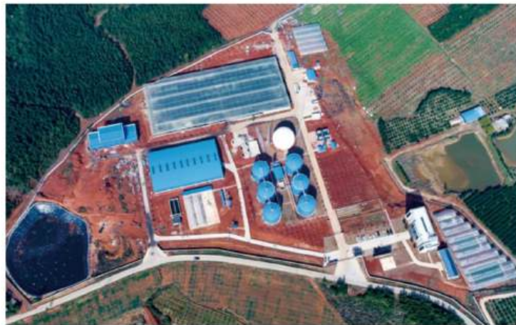
江西新余区域粪污集中处理中心
